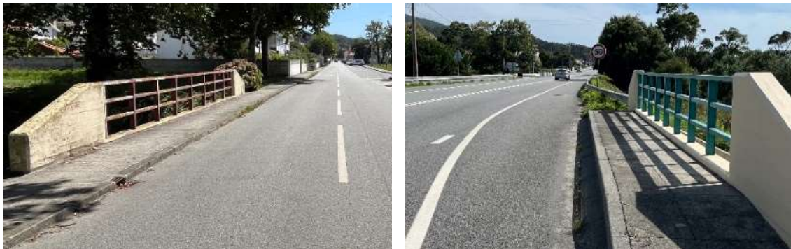
Figura 3: Exemplo de condições de conservação de passagens inferiores contemporâneas (e do mesmo tipo) em estrada secundária municipal (esquerda) e nacional (direita).
